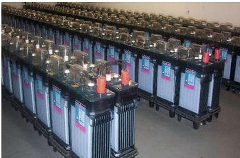
Рисунок 3 – Аккумуляторные батареи цепей постоянного тока подстанции
