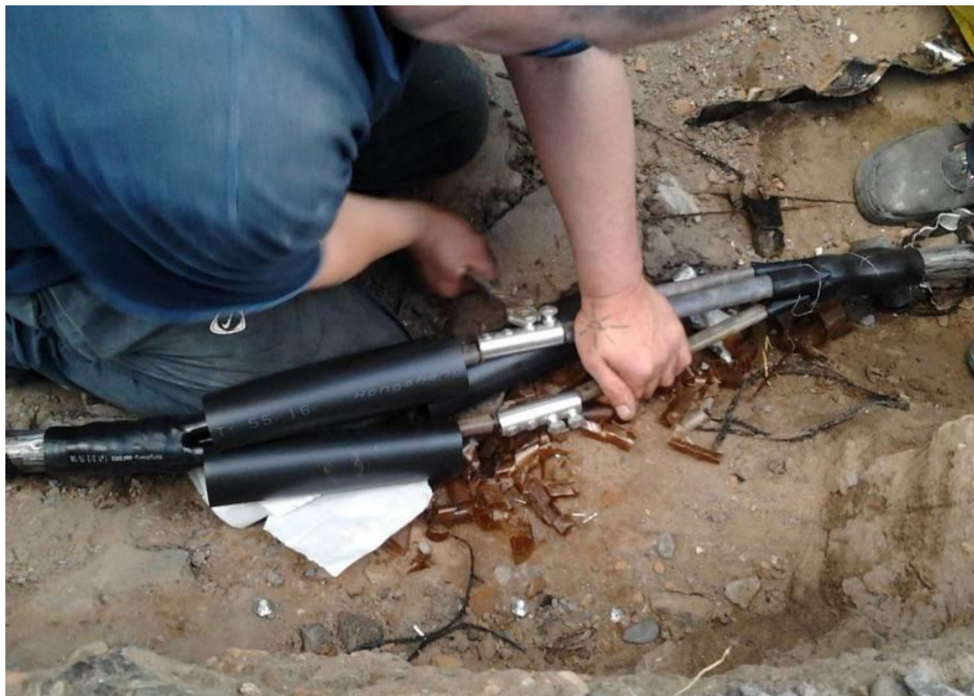
Рисунок 2 - Установка кабельных муфт
