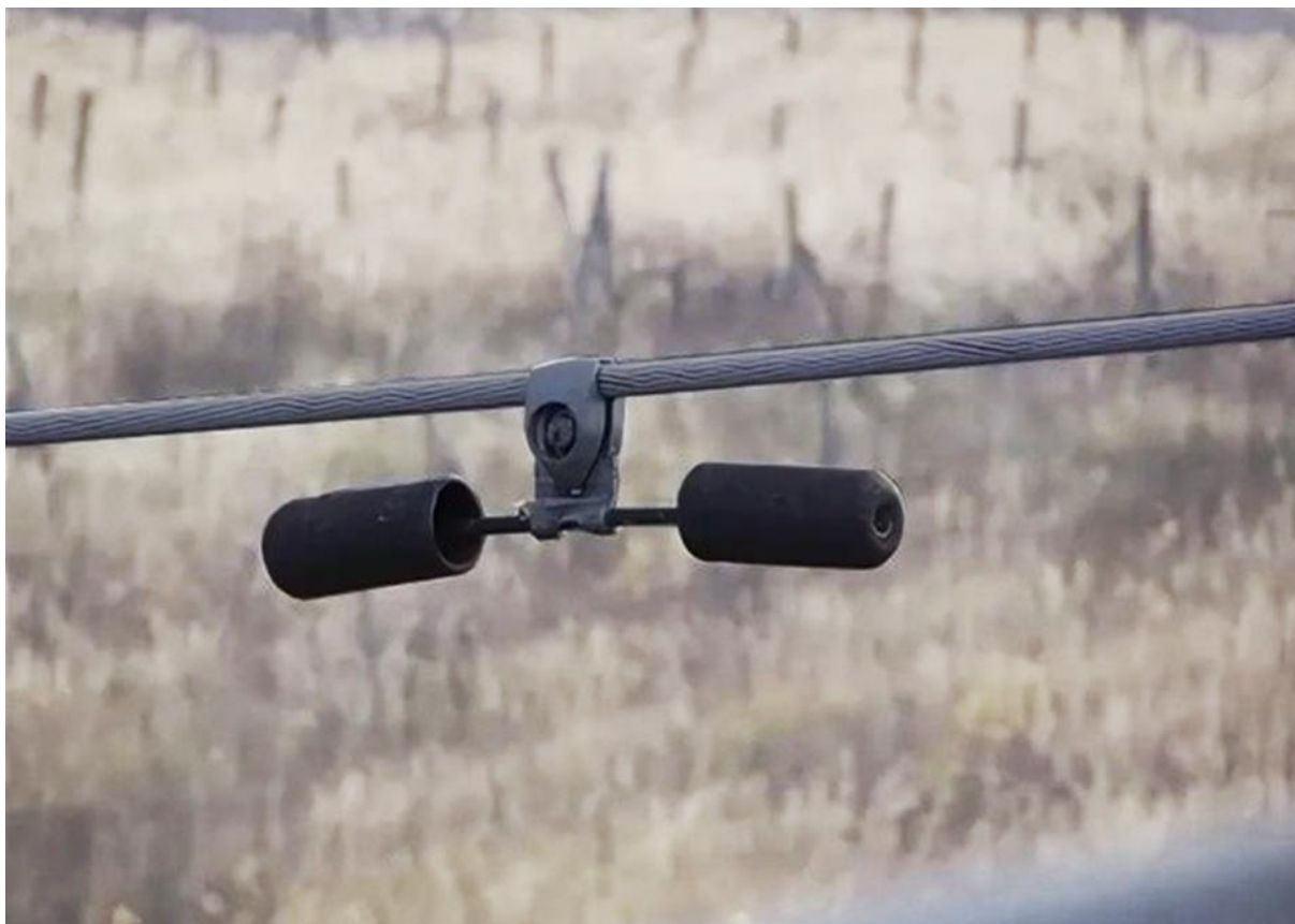
Рисунок 2 –Виброгаситель на ВЛ типа ГПГ
