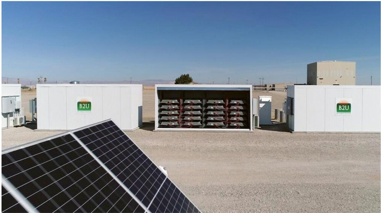
Рисунок 1 – Повторное использование аккумуляторных батарей электротранспорта для аккумуляции электроэнергии СЭС в Калифорнии
